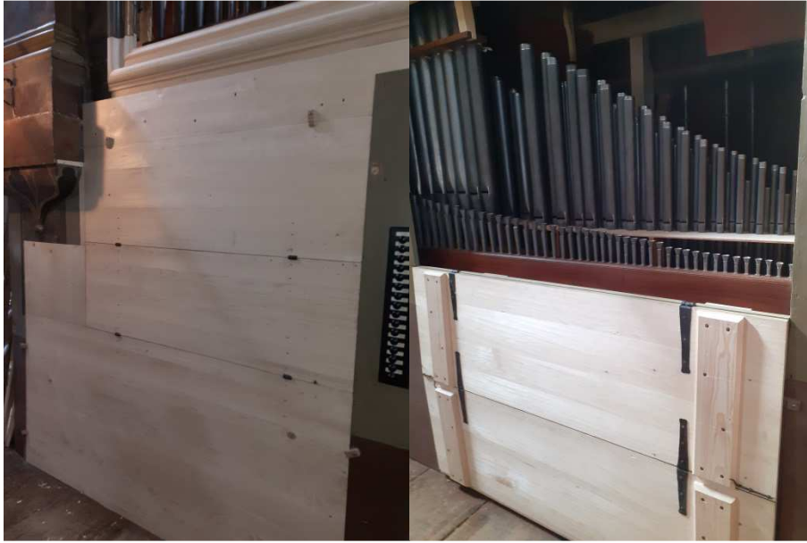
Portelle POS. e cornicione nuovi
